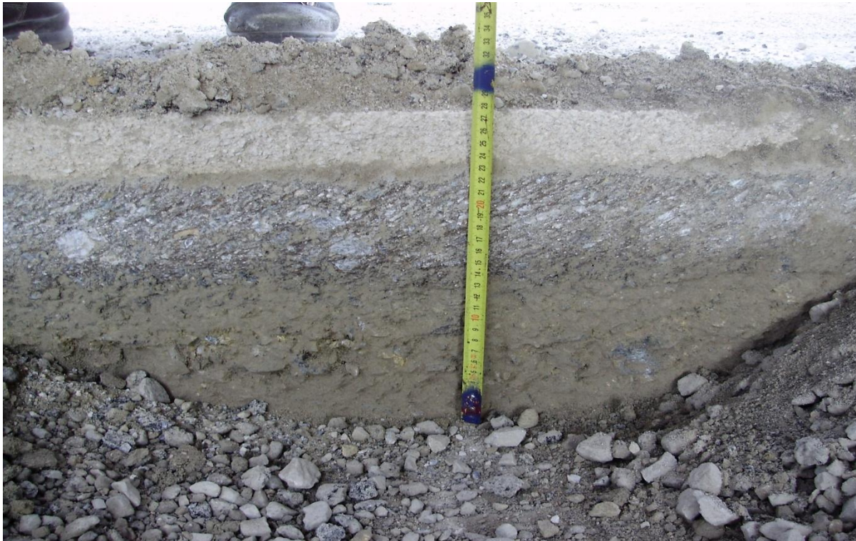
Slika 9. Izvođačka kontrola dubine zahvata stroja WR 2500 S tijekom izvođenja hladne reciklaže ( prikazana dubina zahvata od 28 cm)
