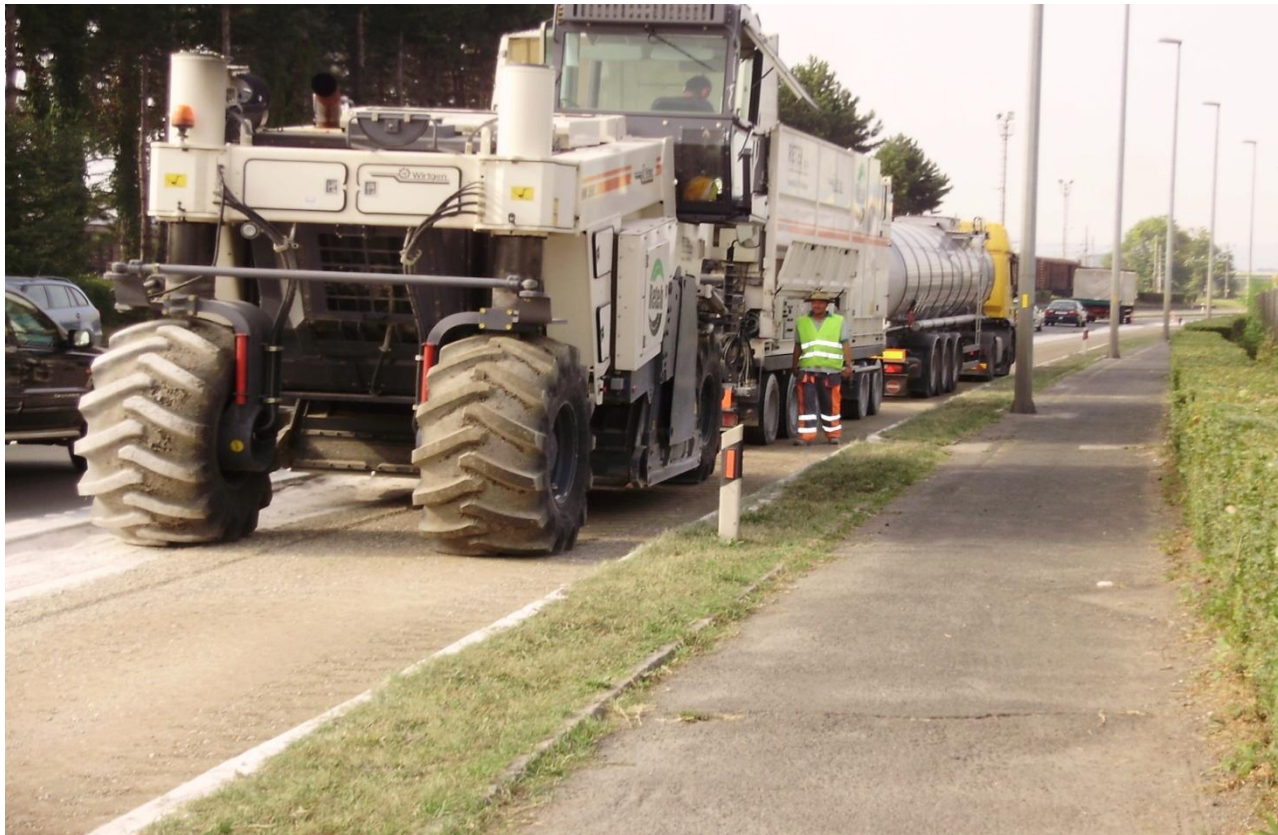
Slika 3. Izvođenje hladne reciklaže pod prometom na Državnoj cesti D1, dionica: brza cesta kroz Grad Karlovac
