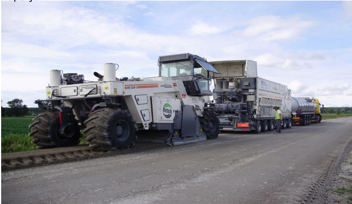
Slika 1. Izvođenje hladne reciklaže na Državnoj cesti D55, dionica: Vinkovci – Županja
