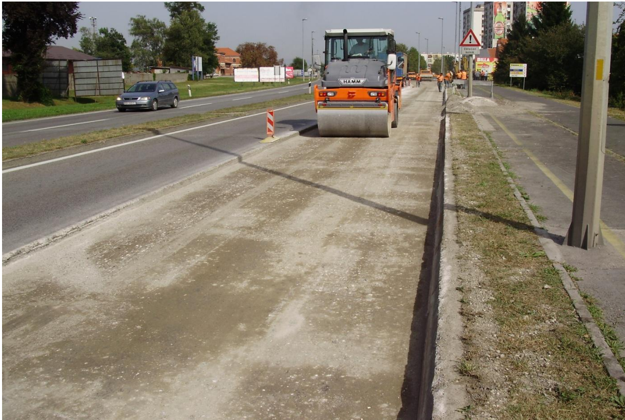
Slika 6. Fino valjanje (peglanje) gotovog reciklažnog sloja
