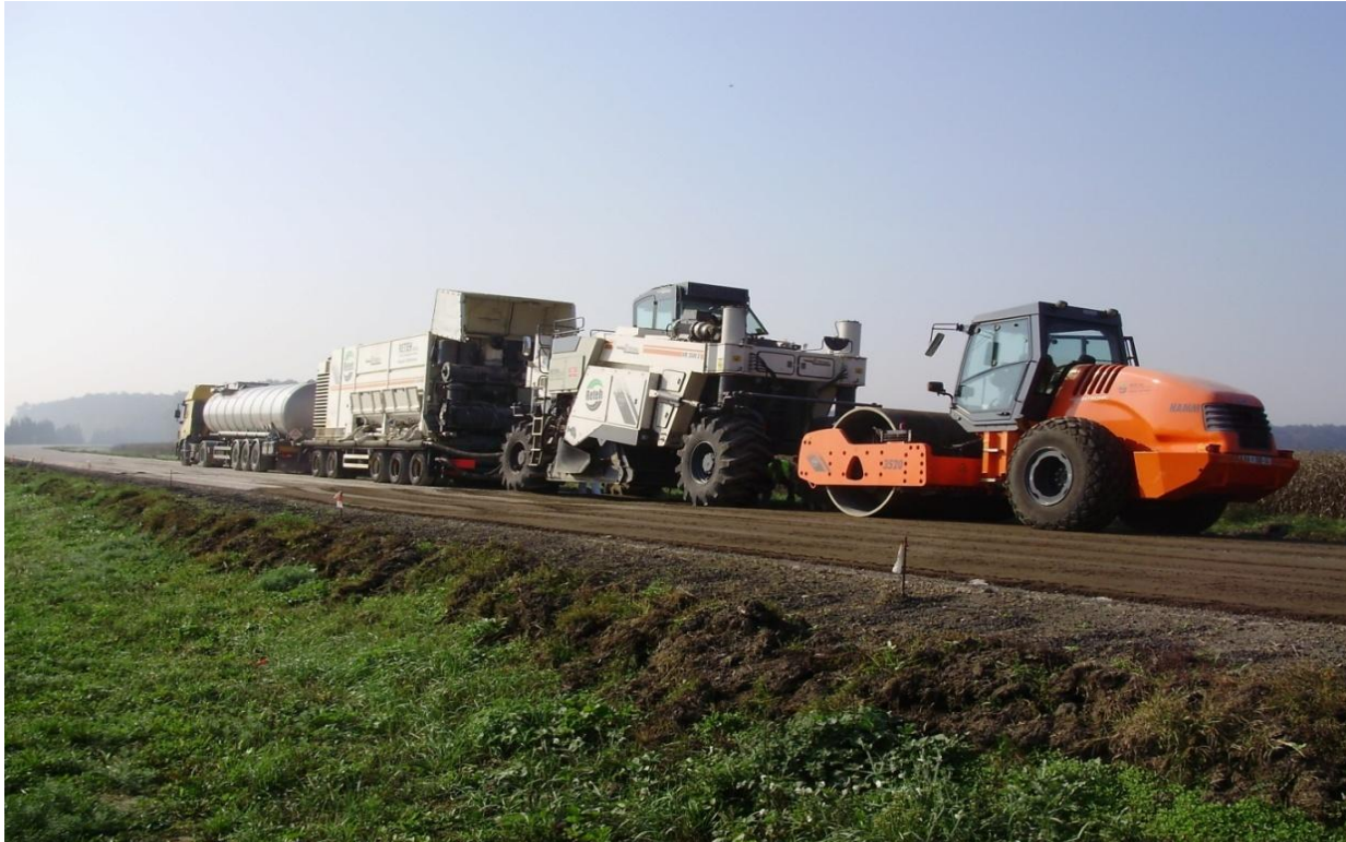
Slika 1. i 2. Prikazuju karakterističan vlak za reciklažu gdje stroj za reciklažu WR 2500 S djeluje kao lokomotiva i gura ispred prikolicu WM 1000 (miješalica za cement i vodu) i cisternu za bitumen kao vodeće vozilo u vlaku.
