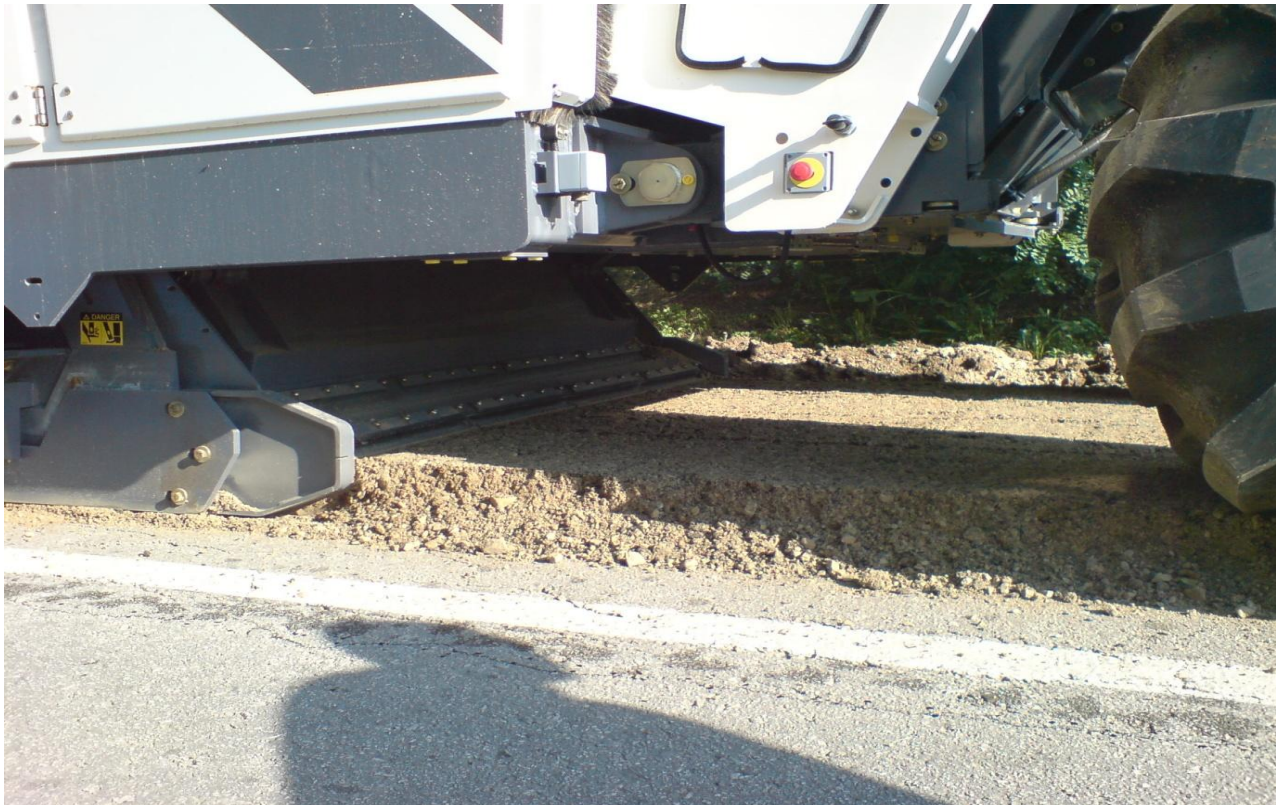
Slika 4. Prikaz zaklopca stražnjeg valjka za glodanje i gotovog reciklažnog materijala koji izlazi iz stroja za reciklažu
